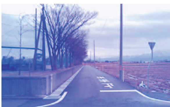
北区美里2丁目地内 光晴中学校グラウンド脇 側溝改良及び道路舗装
