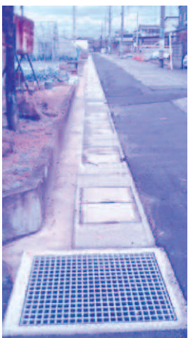
北区嘉山5丁目地内の側溝改良
