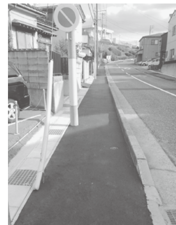
大山台の坂道の側溝にフタが設置されました
